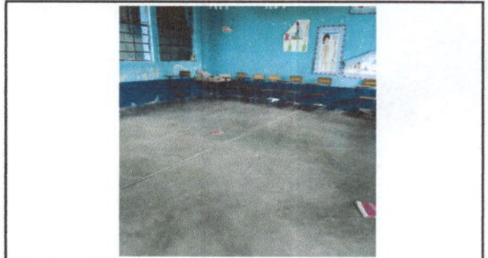
Foto 4: Sustitución de piso de cemento líquido por piso cerámico.
