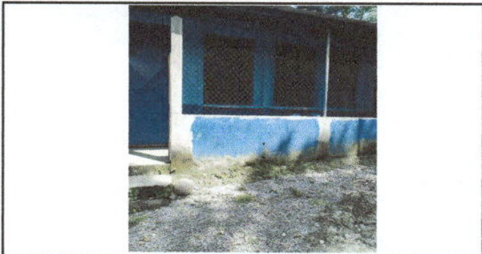
Foto 5: Pintura en muros exteriores e interiores.
