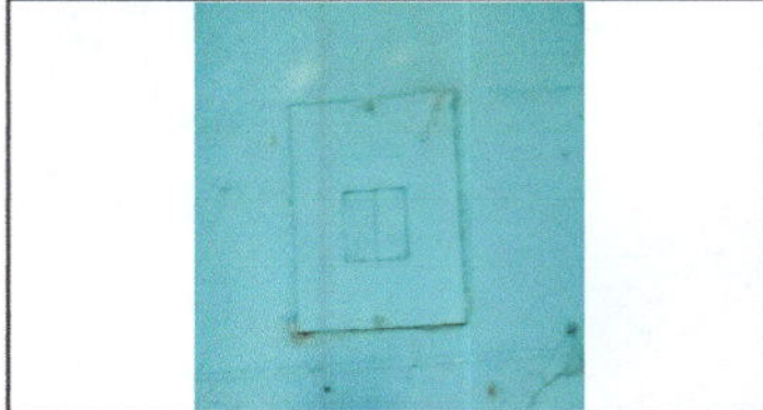
Foto 8: Sustitución de tablero de flipones, flipones, tomacorrientes dobles.
