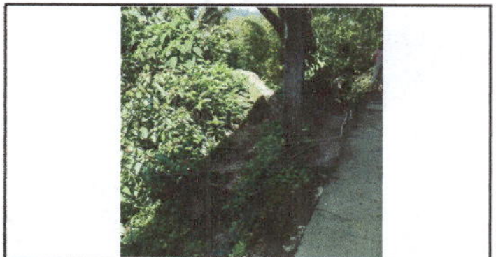
Foto 6: Reparación de tubo HG.
