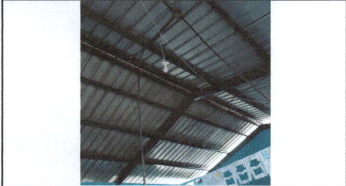
Foto 7: Sustitución de lámparas tipo LED, sustitución de interruptores simples, sustitución de interruptores dobles.
