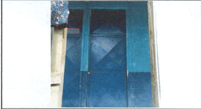
Foto 1: Mantenimiento a estructura (lijado, cambio de tubo, cepillado, sujeción, aplicación de pintura).
